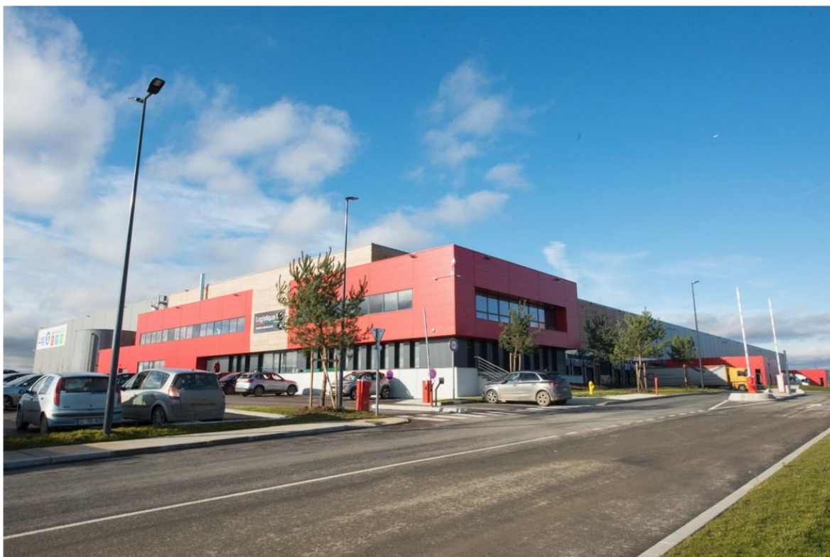
Figure 68 : Bâtiment Logistique NC sur la ZAC de la Butte aux Bergers (source Logistique NC, 2021)
