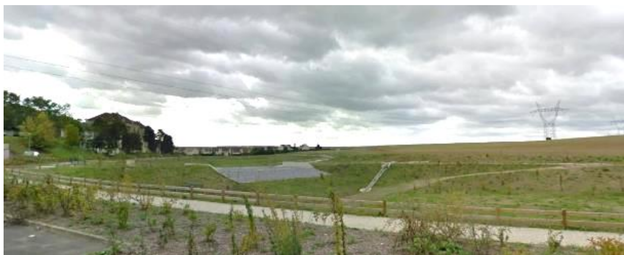
Bassins de rétention du Coudray
