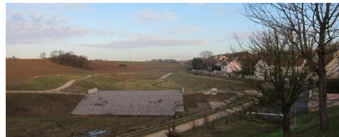
Photo 3 : Vue sur les bassins de rétention - limite entre le bourg de Puiseux et le projet (janv 2014)
